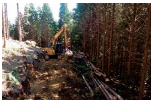
（作業路開設の様子）
